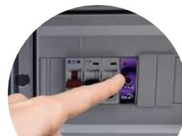
Ce module connecté en Bluetooth® remplace l'ensemble : horloge électromécanique + contacteur + interrupteurs, pour le **pilotage de la pompe et de l'éclairage** via l'application gratuite On.e.
