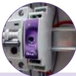
Le module On.e peut être monté dans tous les coffrets électriques WA Conception classiques monophasés (triphases sur demande). La solution On.e est **raccordée et prête à l'utilisation.**
